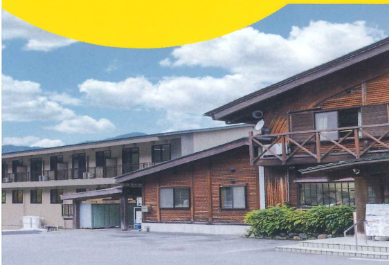
河鹿荘新館・本館
