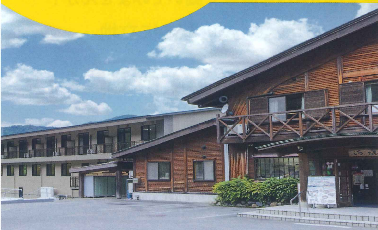
河鹿荘新館・本館
