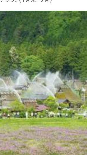
点検のための一斉放水は年に2回。(5月と12月)
