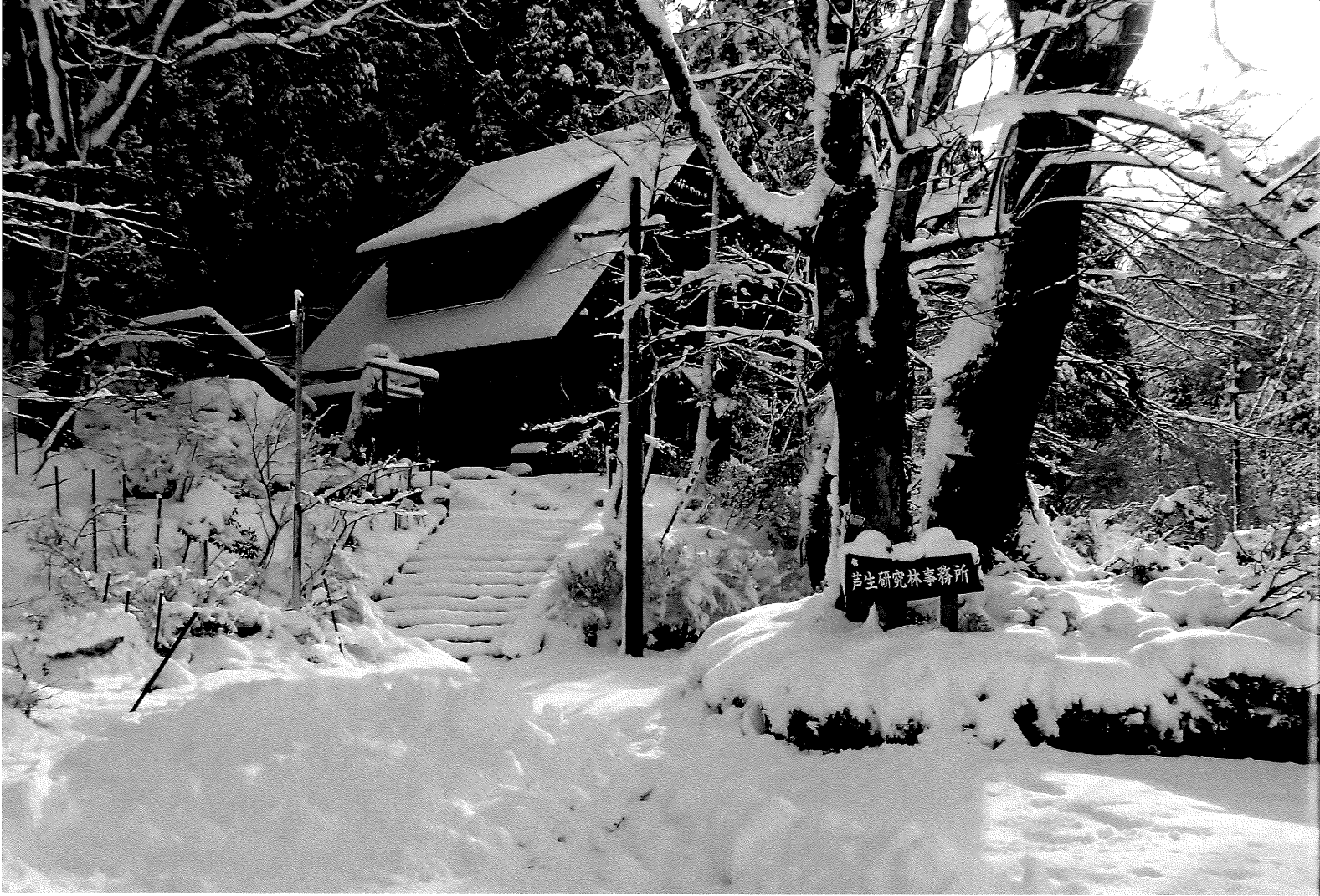
1931年築の事務所棟 Office built in 1931.
