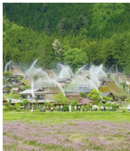
点検のための一斉放水は年に2回。(5月と12月)
